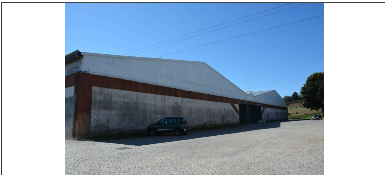
Figura 5.90: Fachada norte do Projeto
