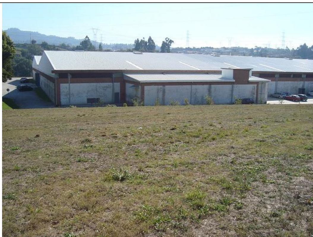
Figura 5.70: Vista parcial das instalações da FACOL a licenciar.
